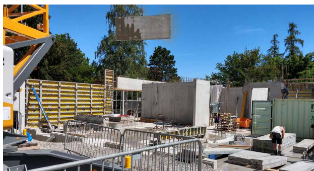
Die ersten Wände des Erdgeschosses sind gegossen.
