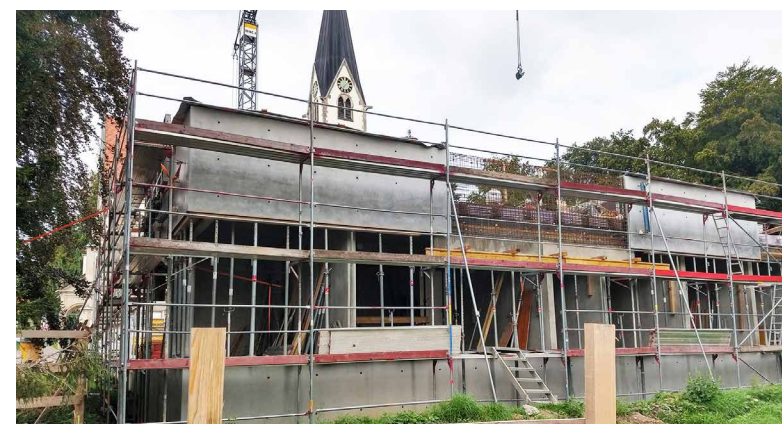
Rohbau von Süden mit den ersten Elementen der Attika-Blenden.
