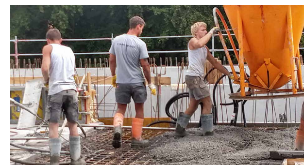
Unmengen von Fertigbeton finden Verwendung beim Betonieren der Dachfläche.
