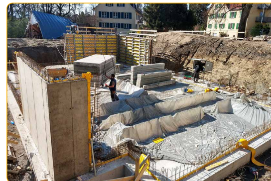
Die Bodenplatte ist betoniert, es folgen die Kellerwände.
