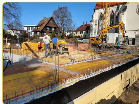
Die Kellerdecke ist fast fertig armiert, kurz vor dem Betonieren.
