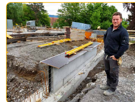
Ein stolzer Polier – es geht gut voran!
