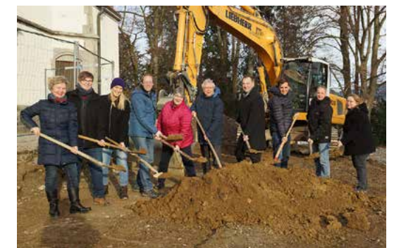
Spatenstich KIEZ am 30.01.2020
